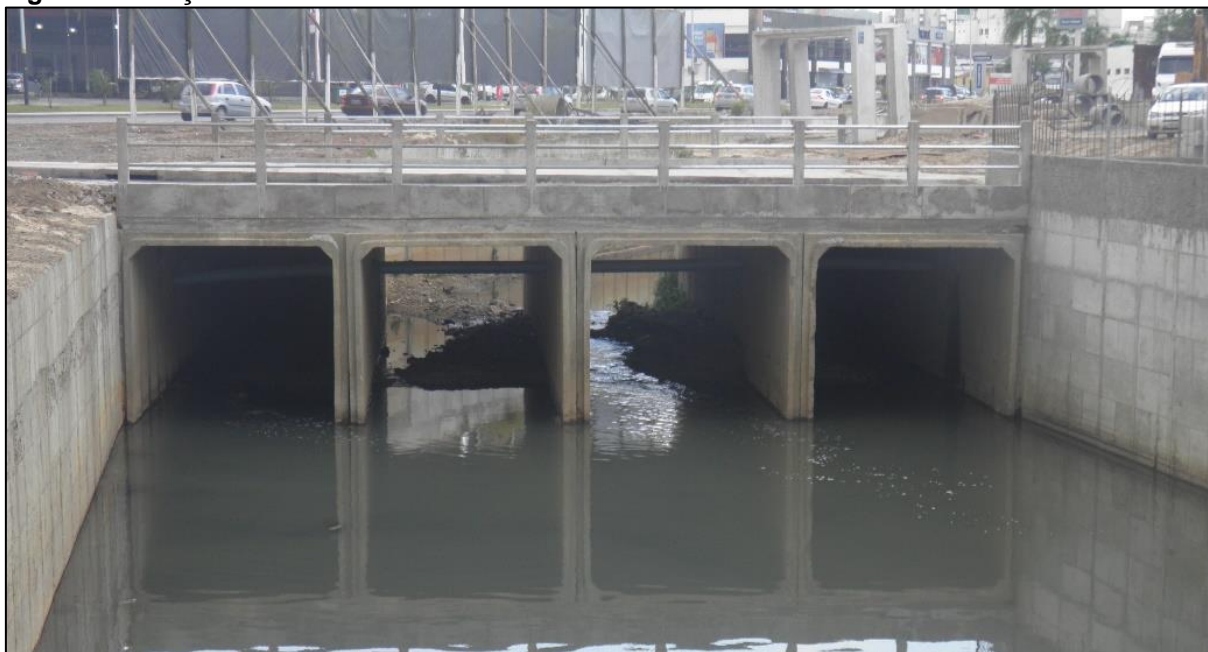
Figura 81 – seção do rio canalizado no final da obra do canal auxiliar.
