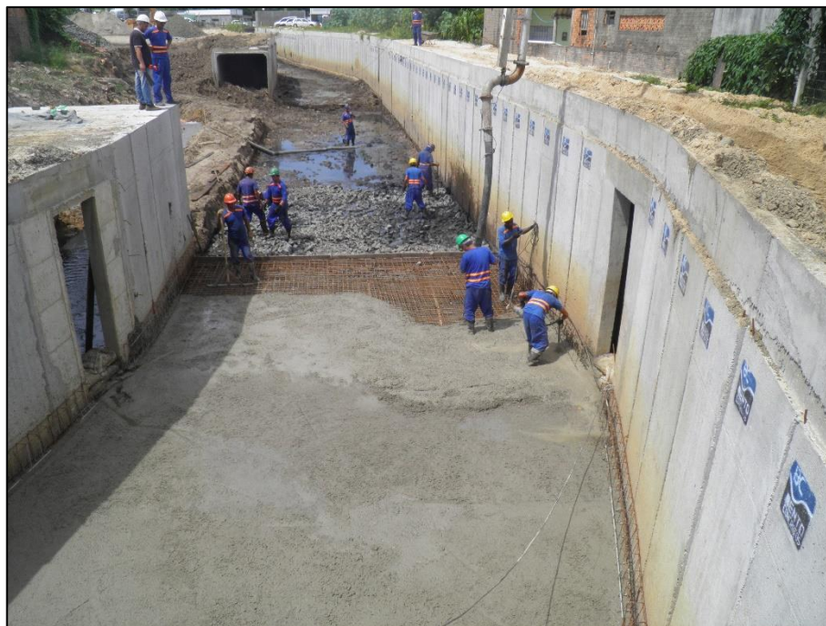
Figura 4 – Trabalhadores concretando a base do atual leito do rio Criciúma.
