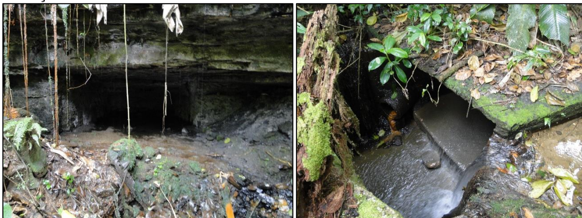
Figura 79 – Galeria de encosta e ponto de entrada de água da oriunda da boca de mina na canalização do rio criciúma.
