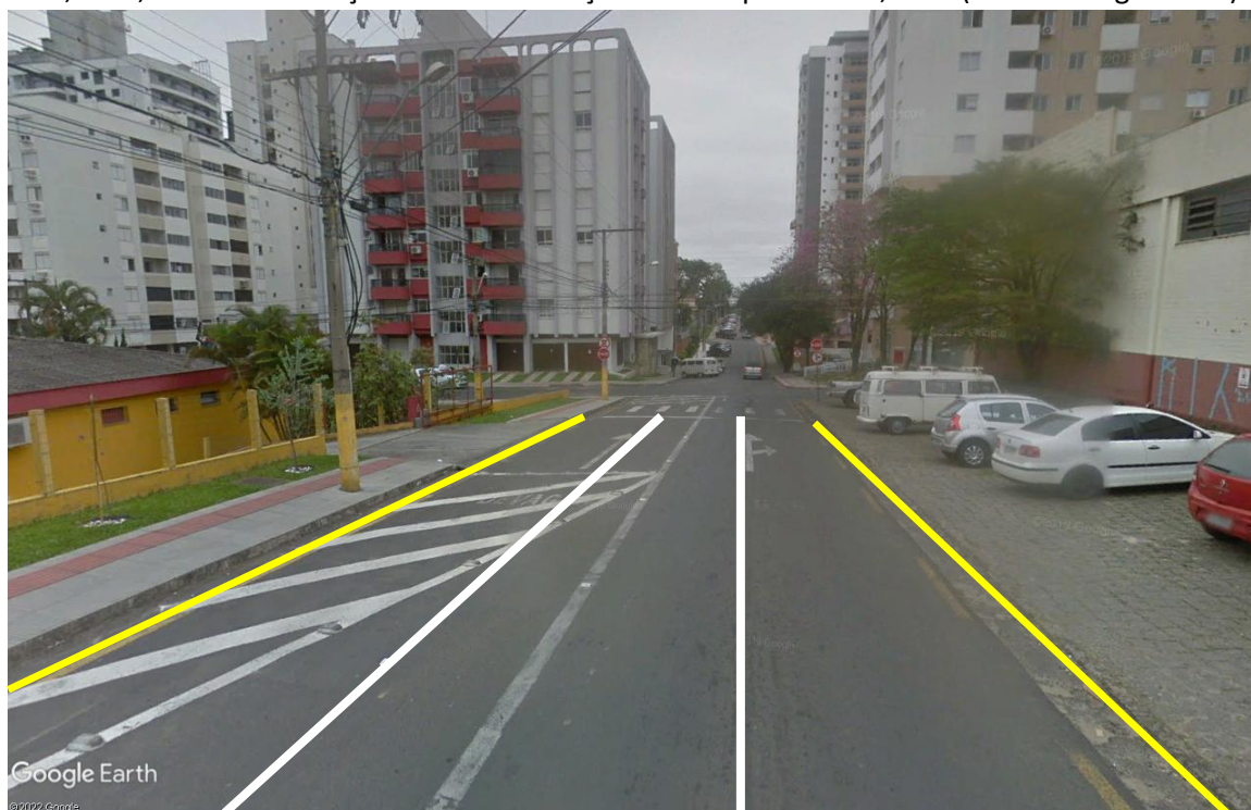
Figura 19: Configuração atual da Rua Vitor Meireles no setor do empreendimento, com duas pistas de 4,50 m, e com a simulação da transformação em três pistas de 3,00 m (Fonte: Google Earth).
