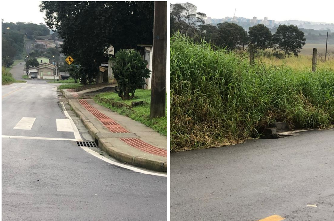
Figura 36: Drenagem pluvial na Rua José Maria da Silva. Fonte: Castelan, 2022
