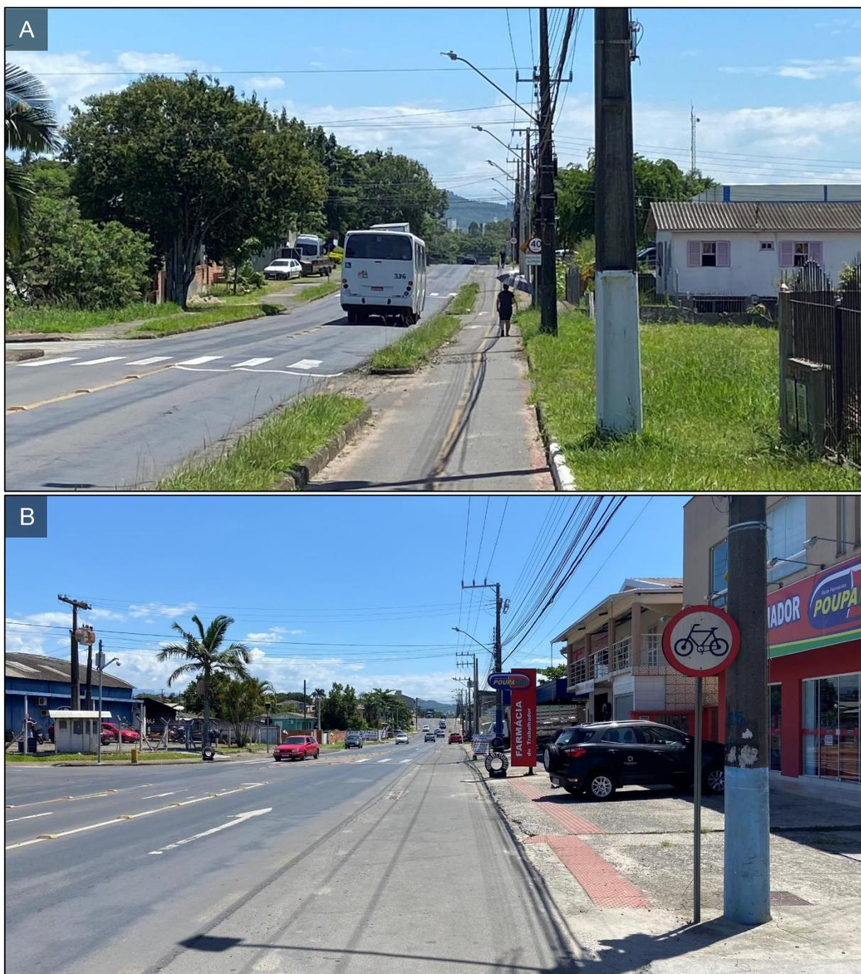
**Figura 115:** A: Ciclovia da Av. Ass. de Deus com ausência de passeio. B: Ausência de Sinalização Horizontal na ciclofaixa da Av. Ass. de Deus.
