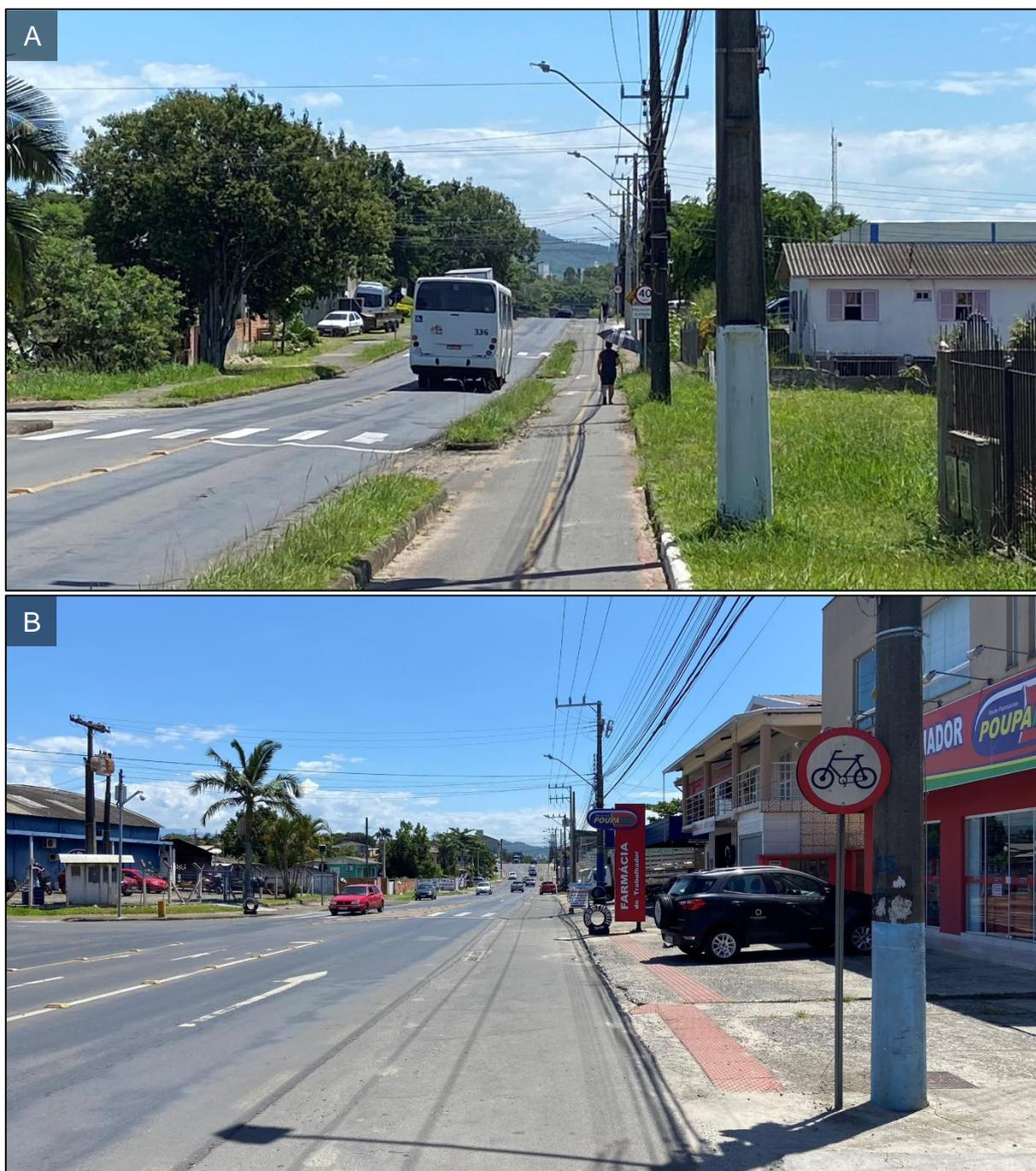
**Figura 106:** A: Ciclovía da Av. Ass. de Deus com ausência de passeio. B: Ausência de Sinalização Horizontal na ciclofaixa da Av. Ass. de Deus.
