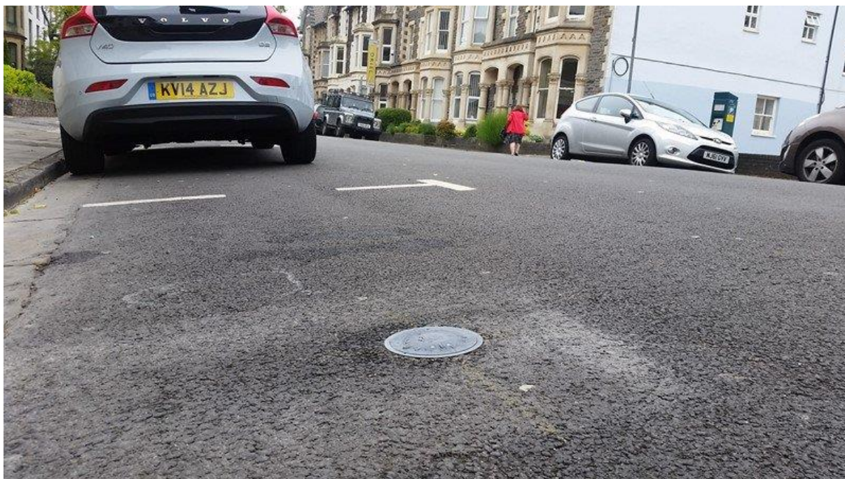
Figura 16: Sensor de estacionamento nas vias públicas da cidade de Cardiff, Reino Unido. Fonte: Smart Parking, 2023.
