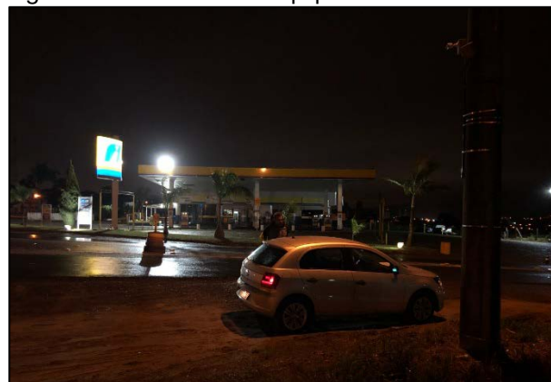
Figura 22: CPM-P003 – Equipamento Instalado.
